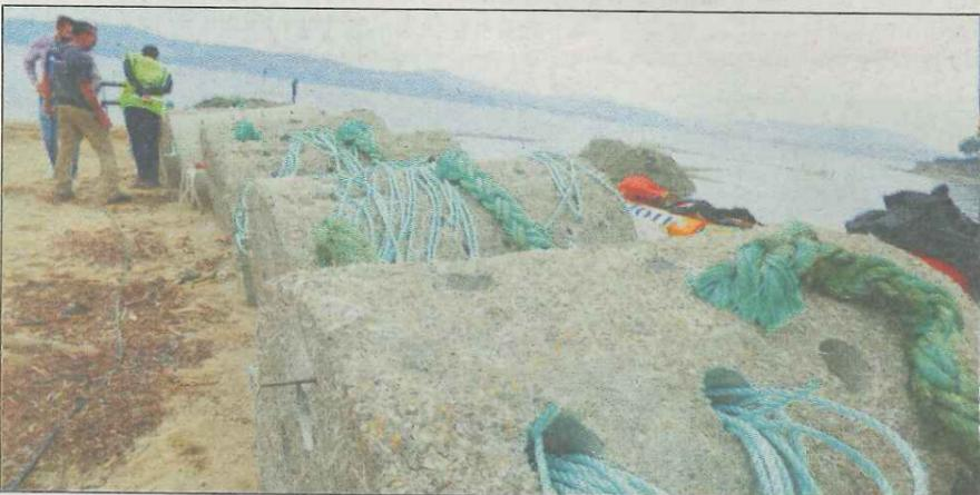
Les récifs artificiels en béton fibré compenseront les perturbations apportées au milieu marin, avec des cavités pour les poissons et des cordes simulant les algues.
